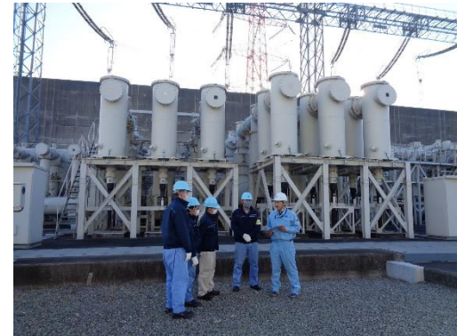
〈電気設備見学〉
